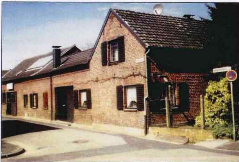
Foto 2: zu Wohnzwecken ungenutzte Hofstelle im Ortskern
