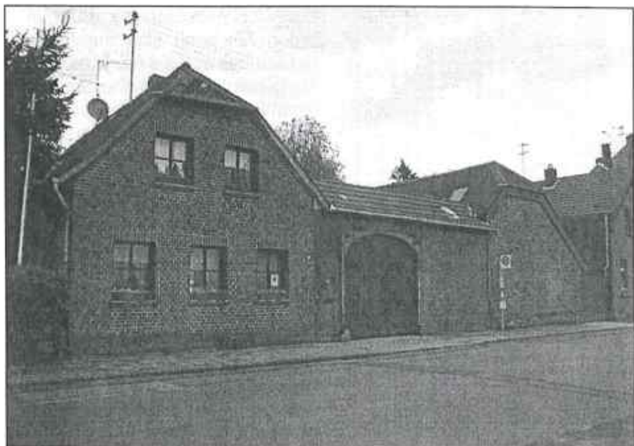
Dreiseithof mit giebelständigem Wohnhaus und Stall. Zur Straße hin bildet ein hohes Hoftor den Abschluß. Hier ein Beispiel mit alten Schnitzereien, welches jedoch sorgfältig restauriert werden muß.
