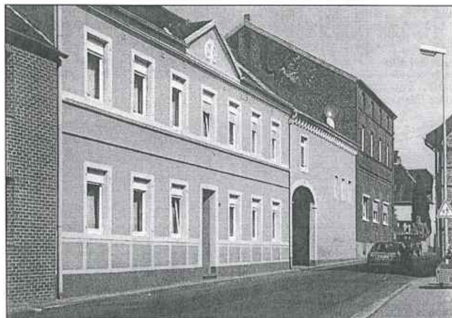
Nach städtischem Vorbild wurden zum Beginn dieses Jahrhunderts auch die Fassaden von Bauernhöfen verputzt und mit Ziergiebeln versehen.
