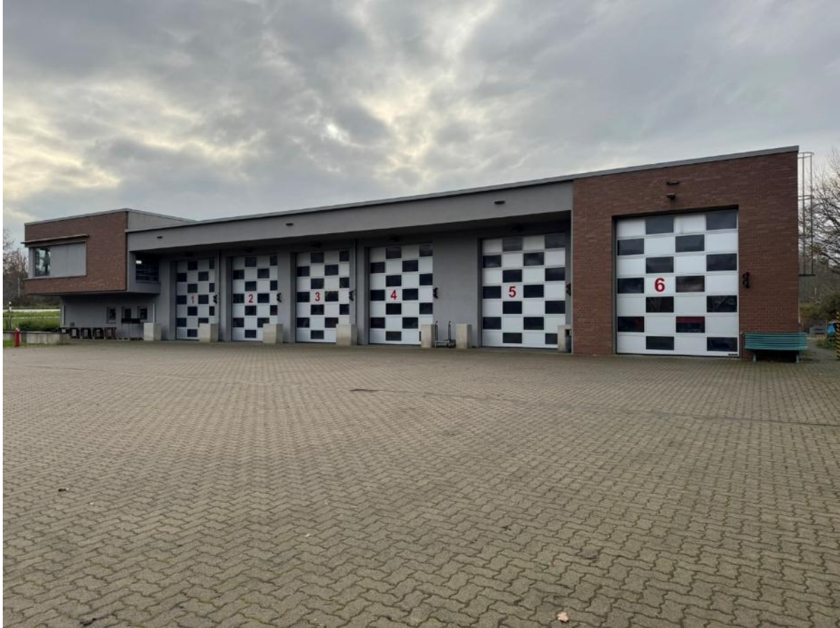
Abbildung 37: Feuerwehrhaus Frimmersdorf/ Neurath
