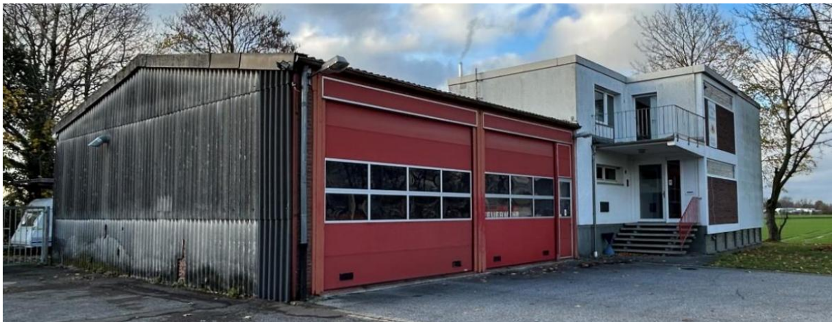
Abbildung 51: Feuerwehrhaus Neukirchen im IST-Zustand
