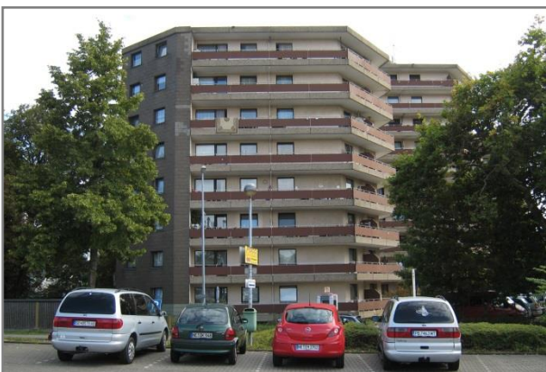
Abb. 23: „Wabenhaus“ am Hammerwerk
