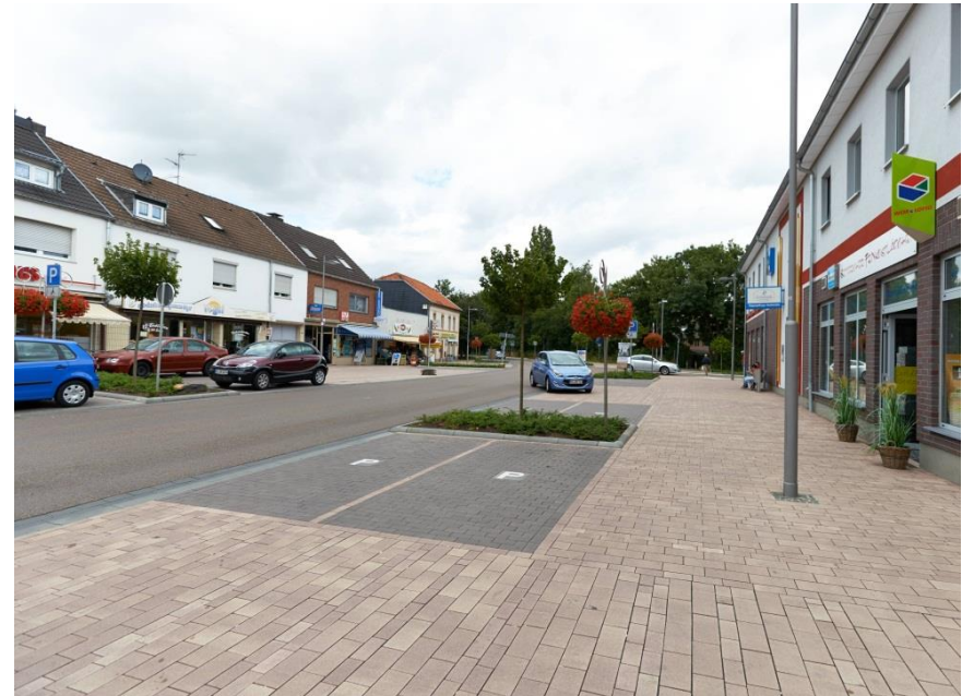
Bsp.: Stadt Baesweiler, Ortsteil Setterich
